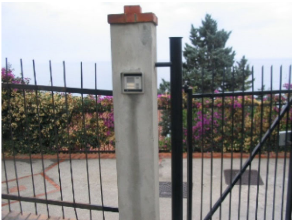
Linker Pfosten mit Klingel und Gegensprechanlage Der Entriegelungsknopf ist auf der Innenseite des Pfostens
